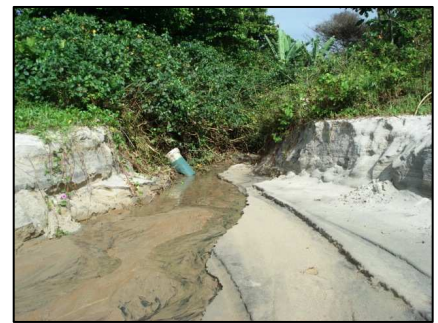
Água drenando em outro acesso à praia
